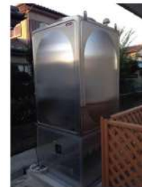
異様な物体? 正体はスプリンクラーの水タンク
